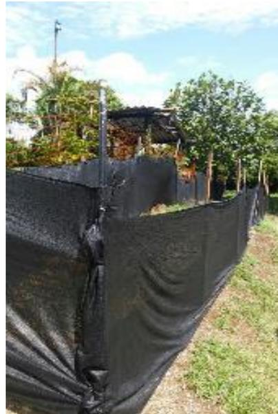
*Figura 6. Encerramientos para dar inicio a construcciones cerca de los espejos de agua*
